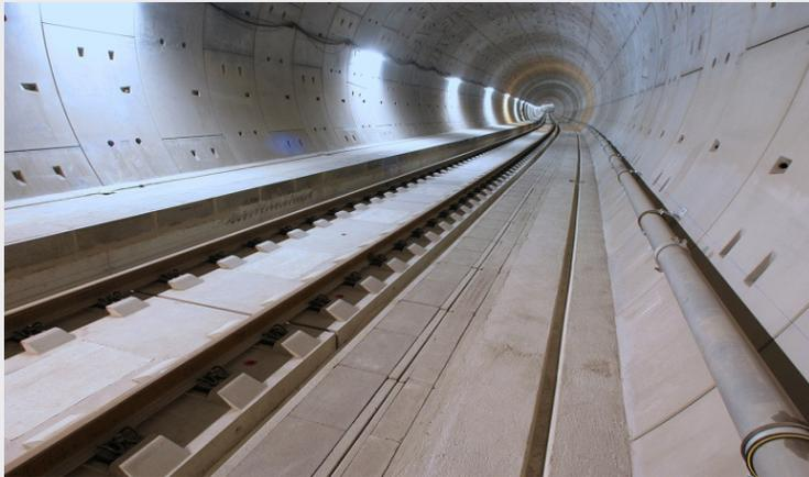
160.000 Gleistragplatten für die Feste Fahrbahn
